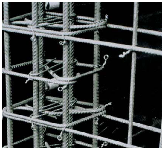
شکل ۳-۱۶- اجرای جزئیات مناسب و شکل‌پذیر در ستون‌ها
