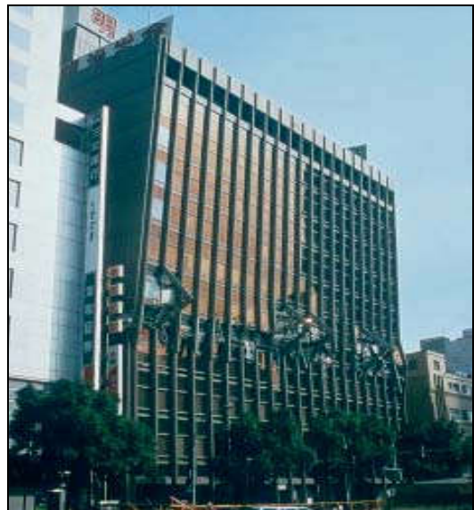
شکل ۳-۲- الف- وجود طبقه نرم در اولین تراز، ب- وجود طبقه نرم در طبقات بالایی
